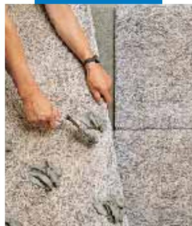
Posa di pannelli isolanti pesanti
