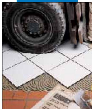
Rifacimento rapido sopra pavimento industriale
