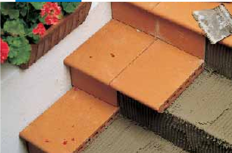
Rifacimento rapido di scala
